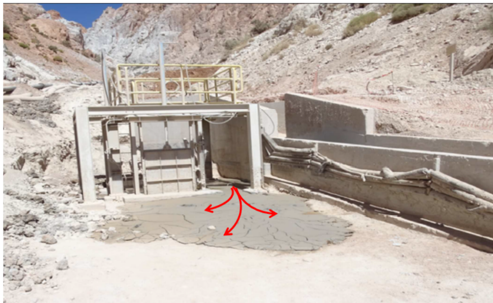
Figura 7: Lamas remanentes después del rebalse. Parte del derrame fluyó directamente por gravedad hacia aguas abajo.
