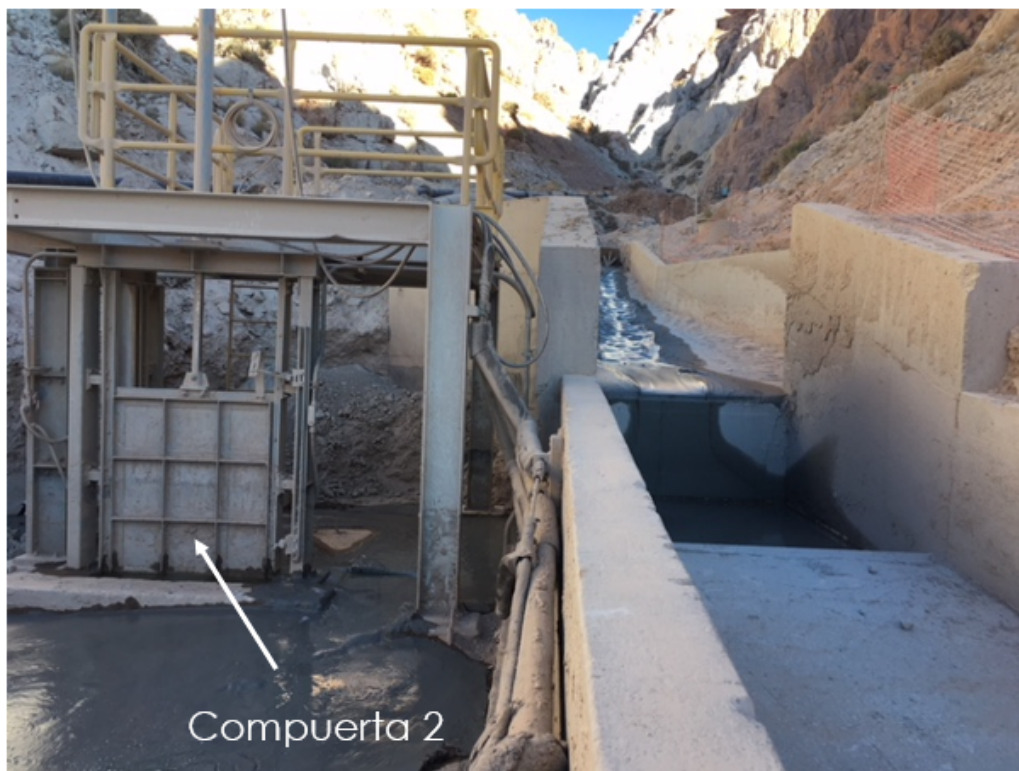
Figura 2: Fotografía del interceptor IP-A2 mirando hacia aguas arriba. Se observan remanentes de lamas en el canal y alrededor de la compuerta producto del rebalse. La Compuerta 2 está en posición abierta.
