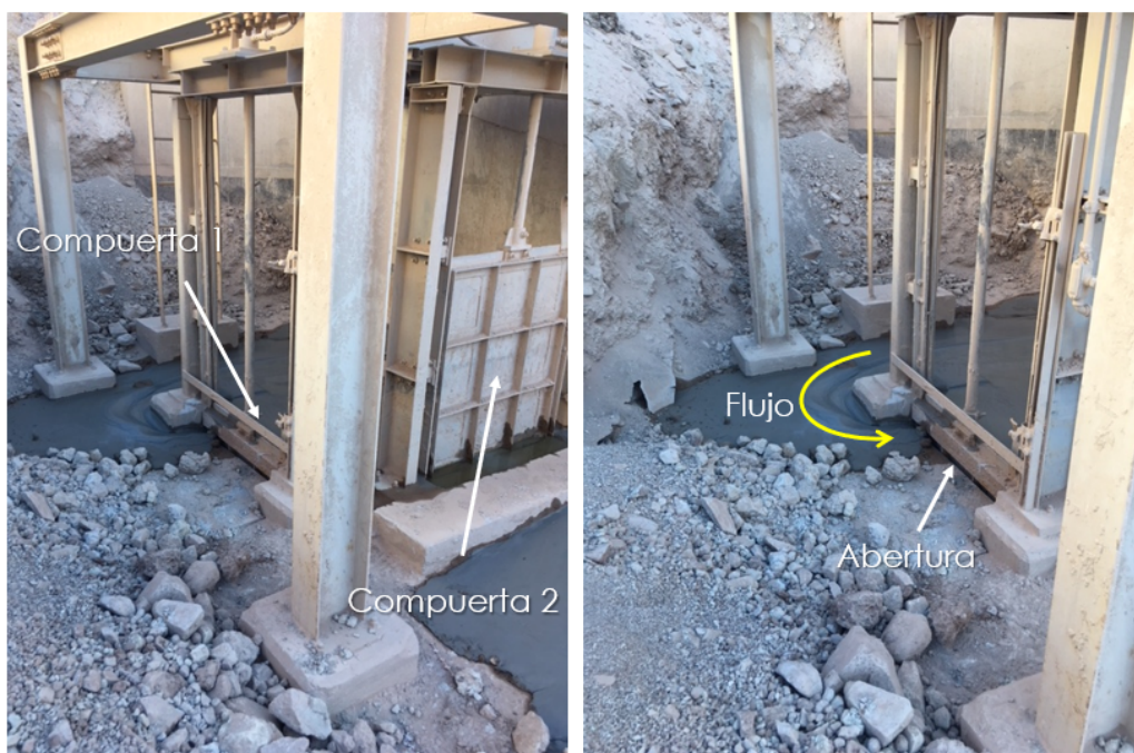
Figura 3: Fotografía del derrame de lamas hacia el canal de aguas lluvias. El rebalse de la cámara desviadora entró por una abertura de la Compuerta 1.
